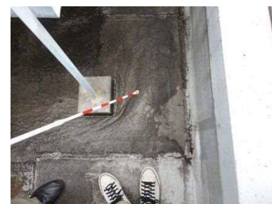
■屋根（防水層）の状況
