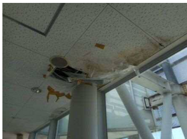
■室内（天井）の状況
