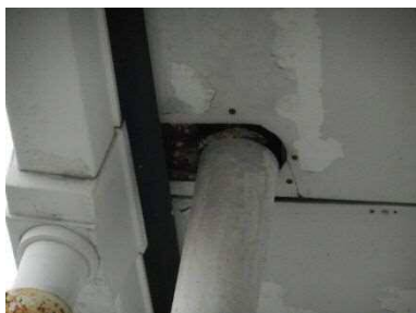
■雨樋（軒裏）の状況
